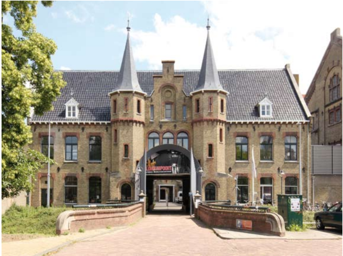
Blokhuispoort anno 2012. Tot 2007 was het poortgebouw in gebruik als Huis van Bewaring.
