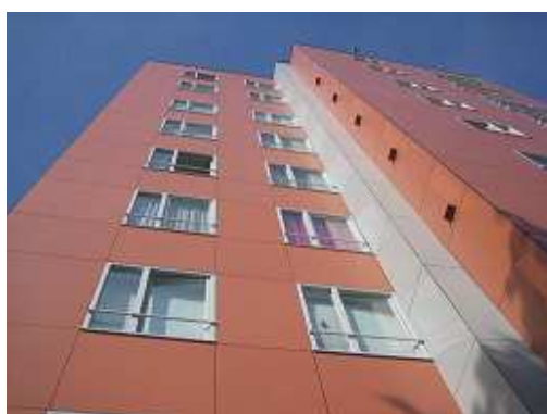
Figuur 12. De Stadhouders, gevel na renovatie.
