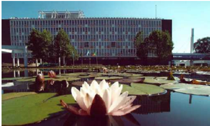
Figuur 14. Het oude AKZO- kantoor De Grote Enk ziet er aan de buitenkant na een ingrijpende restauratie weer net zo uit als in de jaren vijftig.
