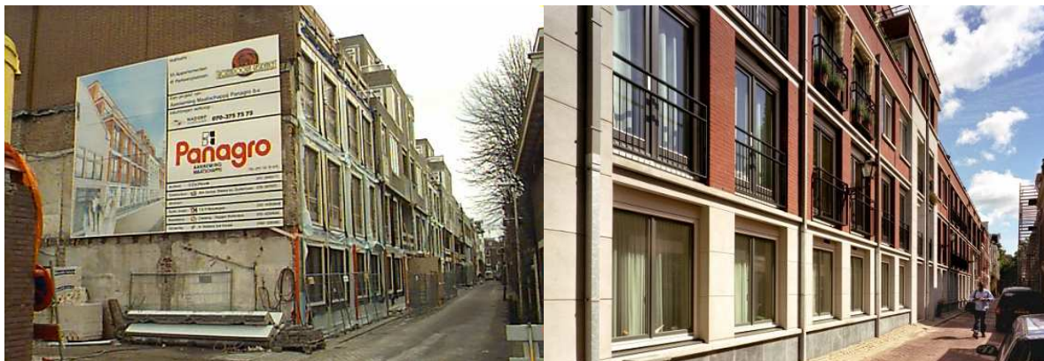
Figuur 20 en 21: Rozendoorn Residence voor en na de renovatie.
